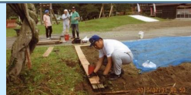
障害児通園施設の砂場整備ボランティア
